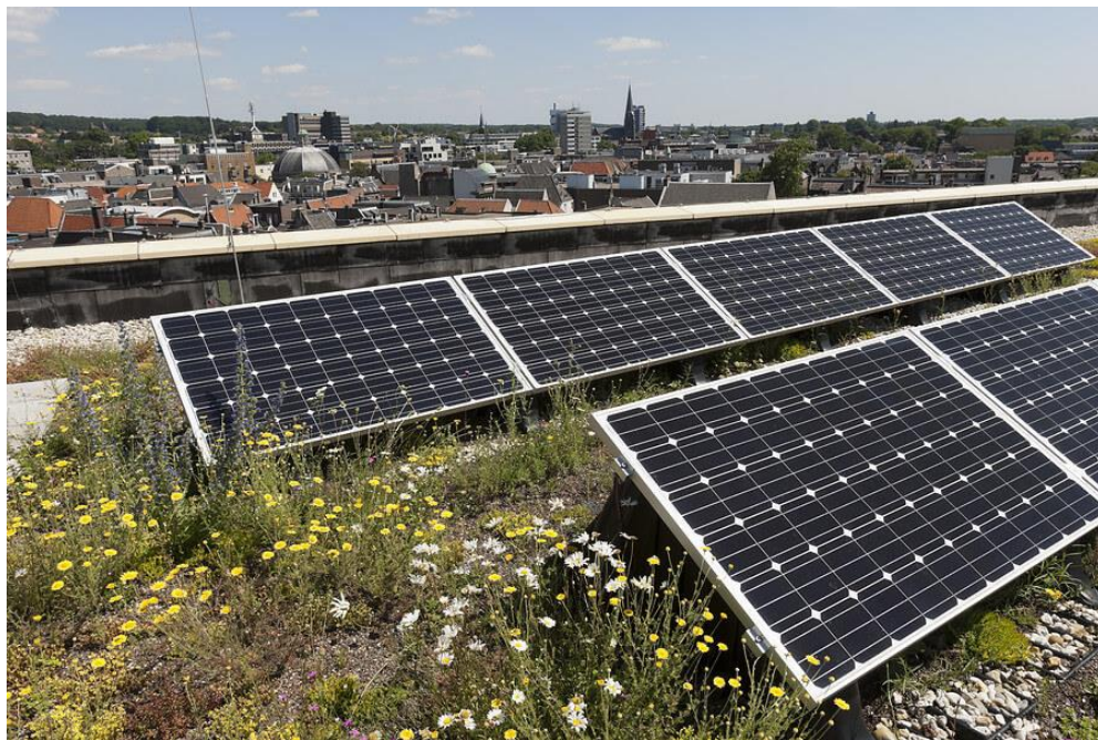
Op plat dak
